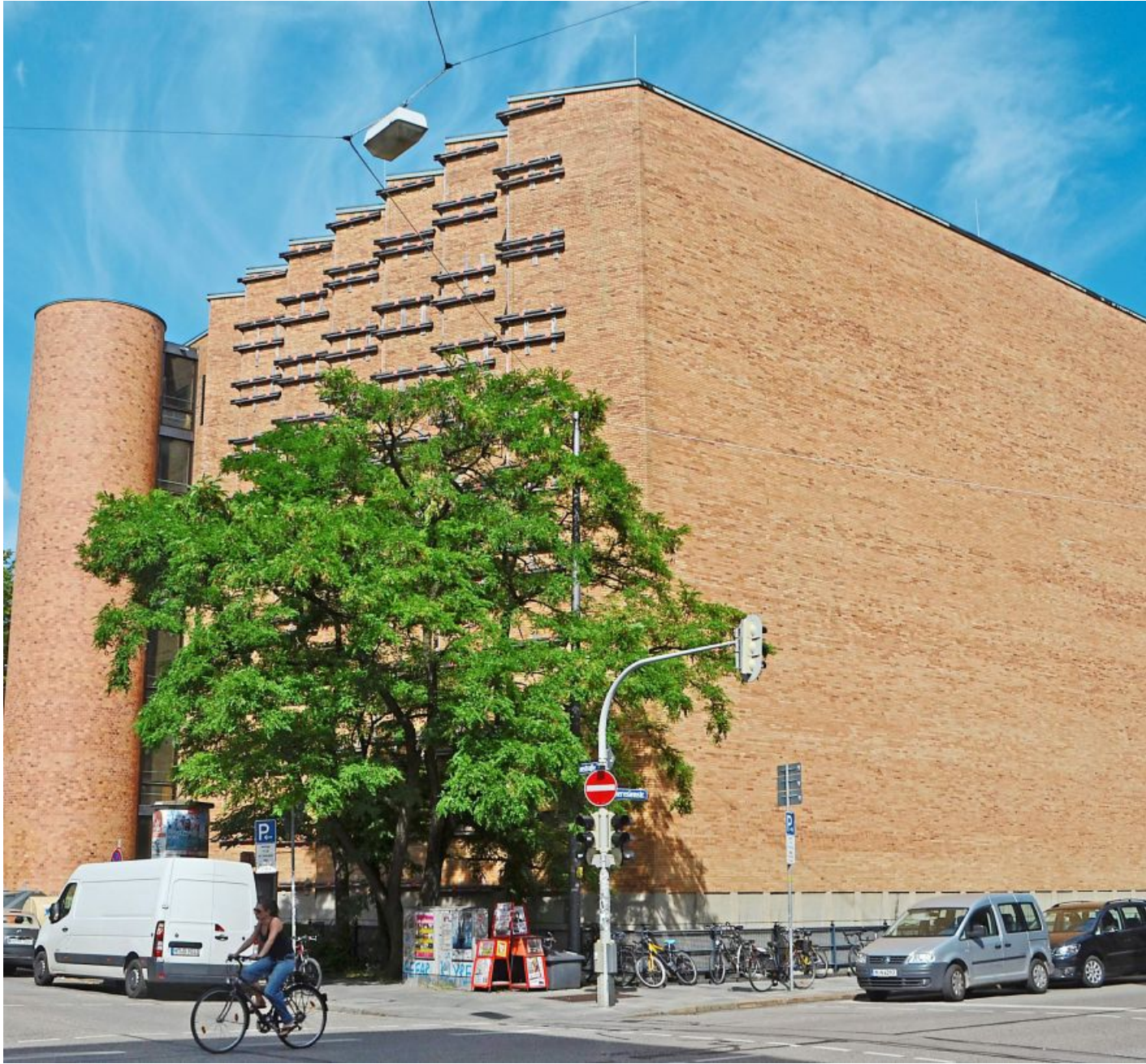
Das Hochvolkshaus der TU München in der Theresienstraße (Ecke Luisenstraße), gebaut zwischen 1957 und 1963, entworfen von Werner Eichberg und Franz Hart. Aufgrund der hohen Spannungen wurde zugunsten massiver Ziegelwände auf leitenden Stahl beim Bau weitestgehend verzichtet.
