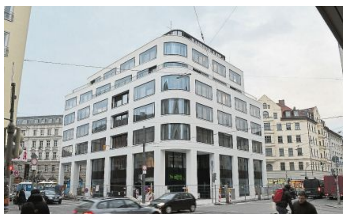
Mäßig: Die zu glatte und gestelzte Gestaltung am „Norkauer Platz“ (Augusten- Ecke Dachauer Straße) ignoriert eitel ihre Umgebung. Die Abstufung der acht Geschosse nach oben ist aber ebenso gelungen wie die Erdgeschosszone im neuen internationalen Stil (Architekten: Kuehn Malvezzi).
