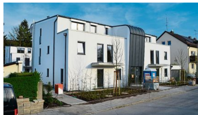
Schlecht: In eine von Einfamilienhäusern geprägte Siedlungsstruktur in Laim wurde eine Wohnanlage mit Gartenhaus eingepflanzt. Trotz unaufgelegter Architektur wird die Anlage zum fremden Element.
