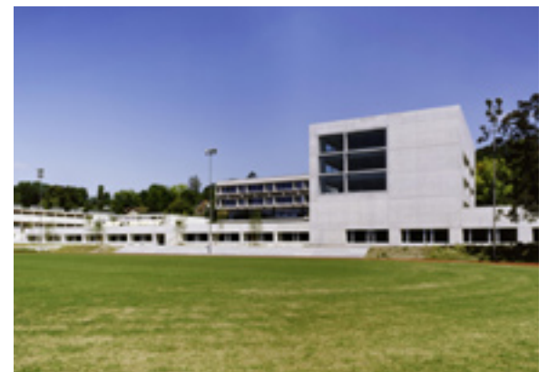
Erweiterung der Kantonsschulen Rychenberg und im Lee, Winterthur (Schweiz)
