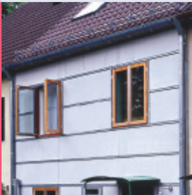
links: Ansicht Nord rechts: neuer Innenraum
