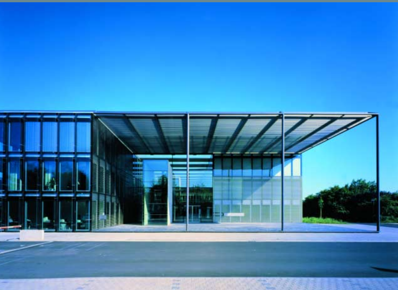
Verwaltungsgebäude der Braun AG Kronberg. schneider+schumacher Architektur, Frankfurt am Main
