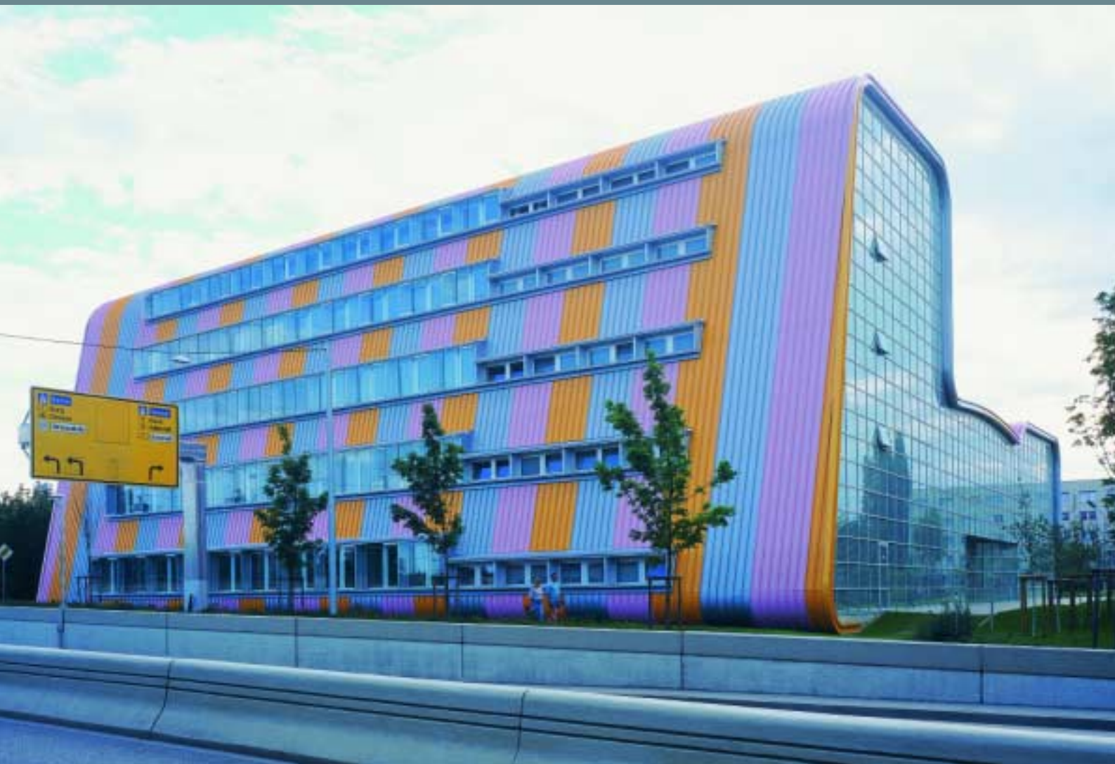
Experimentelle Fabrik Magdeburg. sauerbruch hullton architekten partnerschaft, berlin/london
